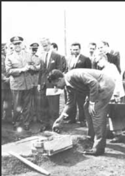
INSTALAÇÃO DA PEDRA FUNDAMENTAL DO HOSPITAL DAS CLÍNICAS DA UFG
